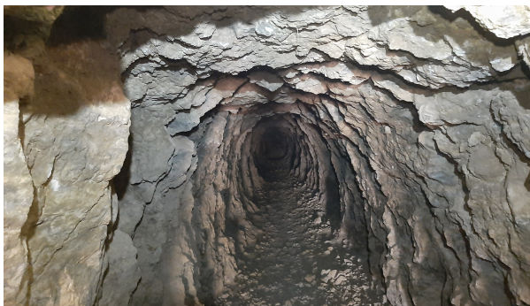
Galerie socavún Hoya Fria
